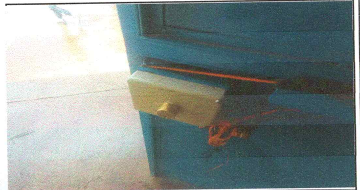
Foto 4: Sustitución de chapas en puerta de metal
