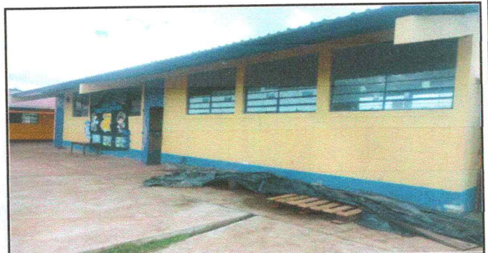
Foto 6: Pintura en interiores y exteriores
