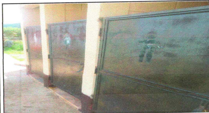
Foto 3: Mantenimiento en puertas
