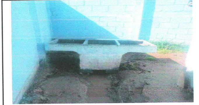
FOTO 2: SUSTITUCION DE PILA DE CONCRETO
