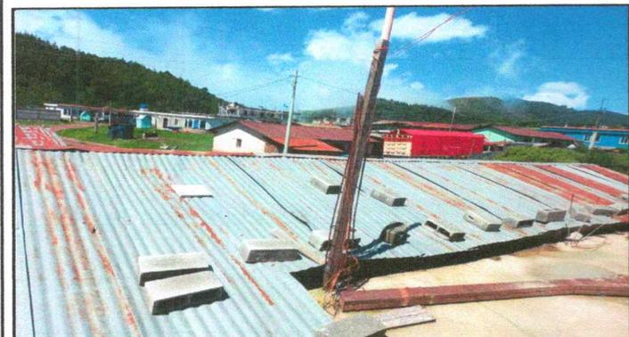
FOTO 4: SUSTITUCIÓN DE LAMINA POR LAMINA TROQUELADA Y CAPOTE TROQUELADO
