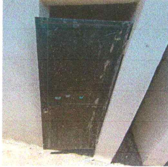
FOTO 1. SUSTITUCION DE PUERTAS DE METAL
