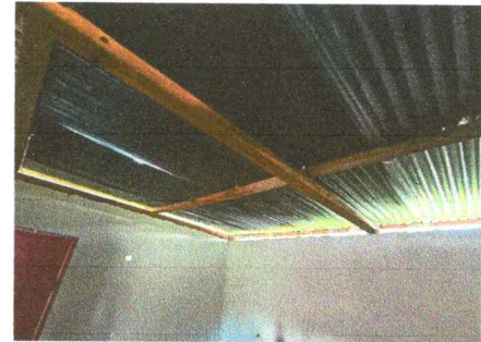
FOTO 2. SUSTITUCION DE SOPORTE DE MADERA POR ESTRUCTURA DE METAL PARA TECHO
