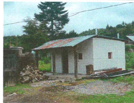
FOTO 6. SUSTITUCION DE LAMINA POR LAMINA TROQUELA MAS CAPOTE TROQUELADO, MAS ELEMENTOS DE FIJACION
