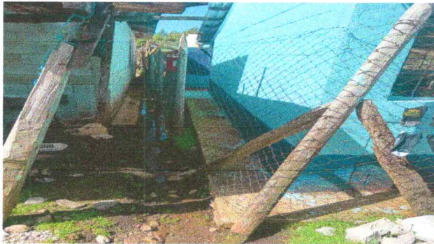
FOTO 3. REPARACION DE MUERO PERIMETRAL DE MALLA MAS TUBO HG
