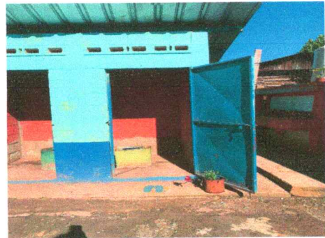
FOTO 4 Sustrucción de inodoros, por baños lavables
