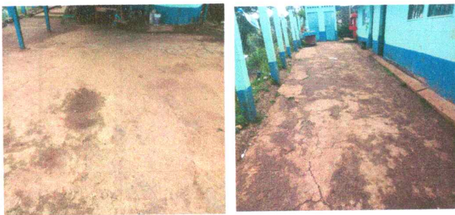
FOTO 5 Reparación de planchas de concreto de patio
