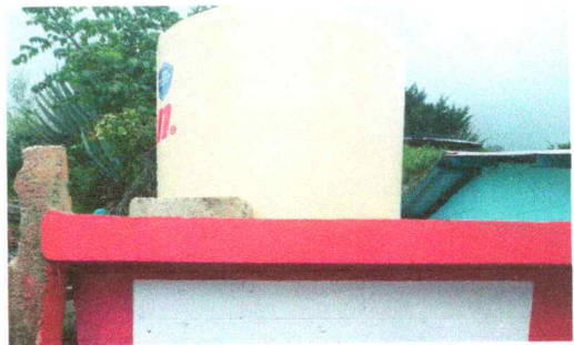
FOTO 6 Sustrucción de depósitos de agua
