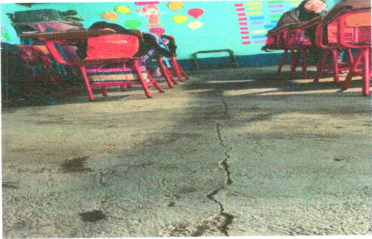
FOTO 1 Sustrucción de piso de torta de concreto, por piso de granito
