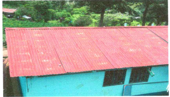
FOTO 2 Sustrucción de lámina, por lámina troquelada aluzinc calibre 26
