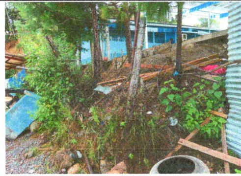
FOTO 6: REPARACIÓN DE TUBO HG Y MALLA GALVANIZADA
