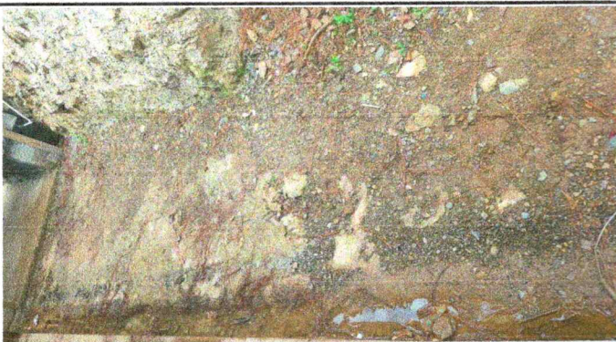
FOTO 3: SUSTITUCIÓN DE PISO DE CONCRETO
