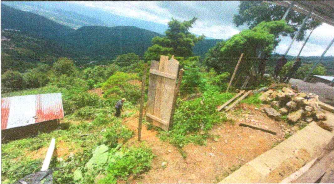
FOTO 1: SUSTITUCIÓN DE PUERTA DE MADERA, POR METAL
