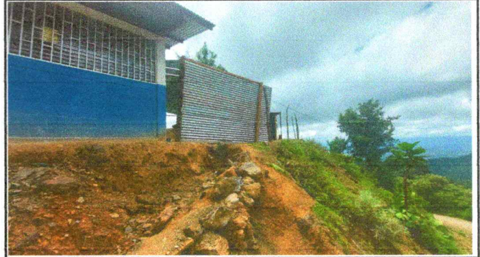
FOTO 2: SUSTITUCIÓN DE PORTÓN DE LÁMINA, POR METAL
