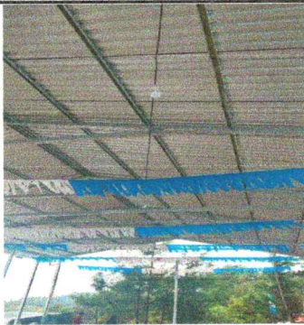
FOTO 5: REPARACIÓN DE SISTEMA ELÉCTRICO
