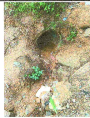
FOTO 4: SUSTITUCIÓN DE CAJA DE REGISTRO
