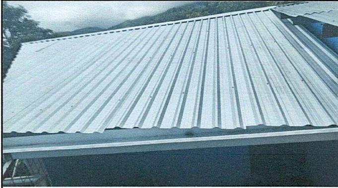
Foto1: Sustitucion de lamina por lamina troquelada calibre 26
