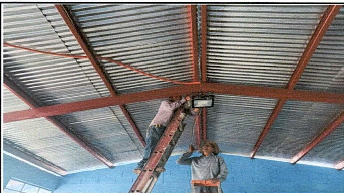
Foto 11: Reparación del sistema eléctrico
