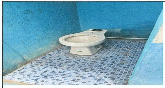
Foto 6: Sustitucion de Sanitarios
