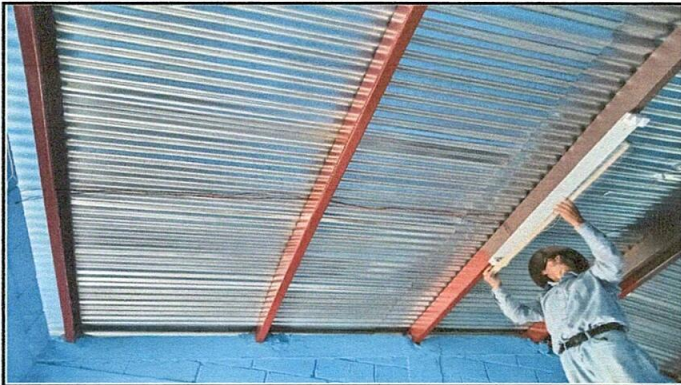
Foto 3: Mantenimeinto a estructura de metal
