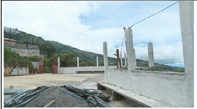
Foto 14: Repello en paredes y muro perimetral
