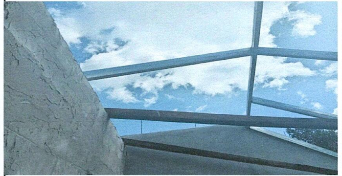
Foto 2: Sustitución de Estructura de madera por metal
