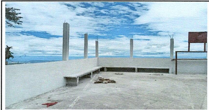
Foto 10: Reparación de muros perimetrales
