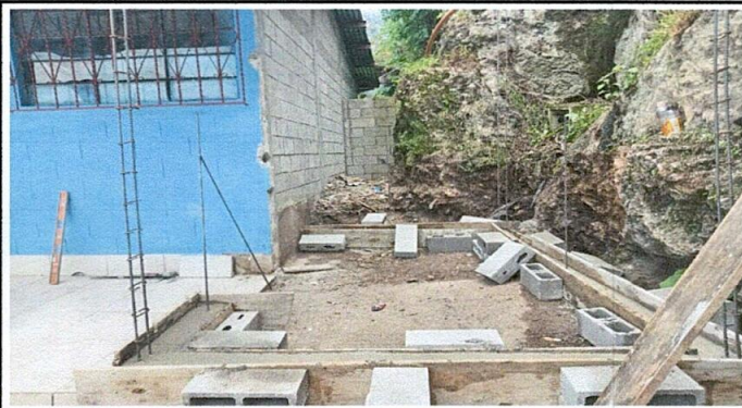
Foto 15: Arreglo de la Bodega
