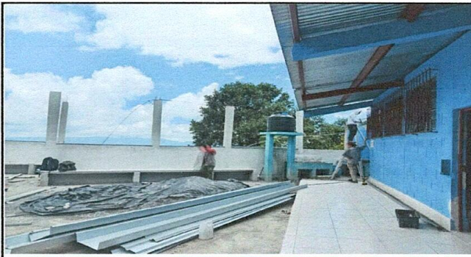
Foto 5: Instalación de Canal calibre 26
