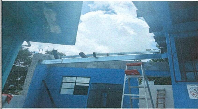
Foto1: Sustitucion de lamina por lamina troquelada calibre 26
