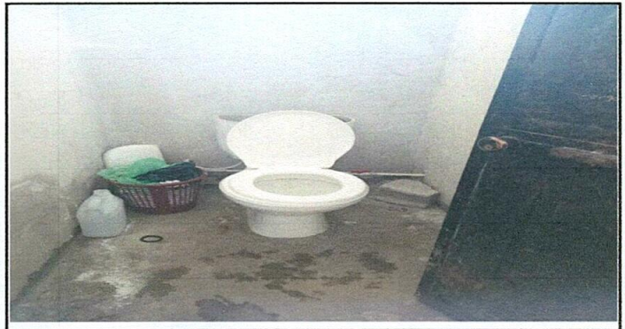
Foto 6: Sustitucion de Sanitarios
