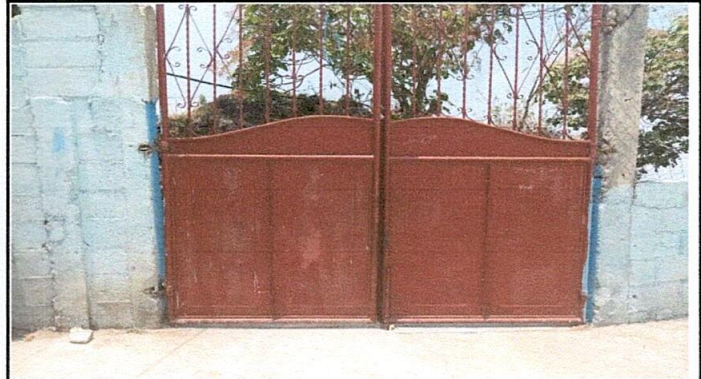
Foto 8: Mantenimiento a porton
