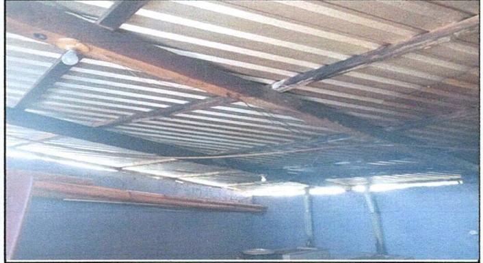
Foto 2: Sustitución de Estructura de madera por metal
