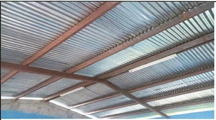
Foto 3: Mantenimeinto a estructura de metal
