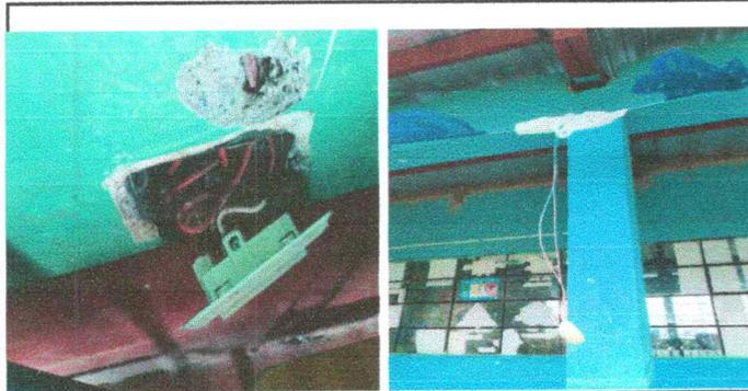
Foto 5: SUSTITUCIÓN DE TOMACORRIENTES E INTERRUPTORES DOBLES
