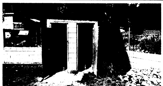
Foto 8: Sustitución de puertas de servicios sanitarios
