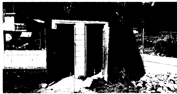
Foto 9: Sustitución de lámina por lámina troquelada A 100 Aluzinc calibre 26 de 12 pies del área de baños
