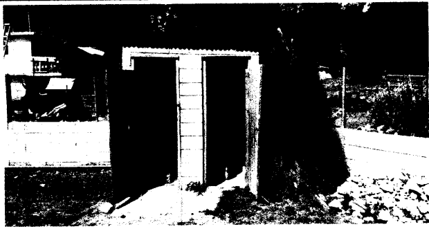
Foto 1: Sustitución y mejoramiento de pared de baños
