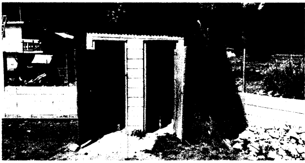
Foto 7: Sustitución de base y letrinas en sanitarios
