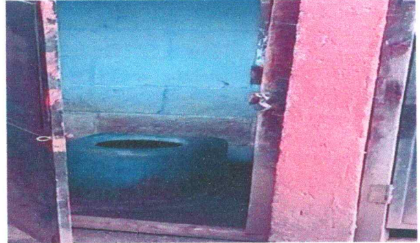
Foto 2: SUSTITUCION DE INODORO
