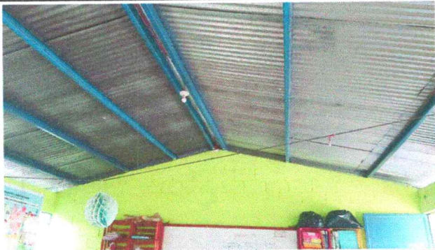
FOTO 5: SUSTITUCIÓN DE ESTRUCTURA DE METAL
