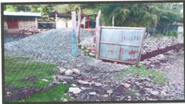
Foto 5: SUSTITUCION DE PORTÓN
