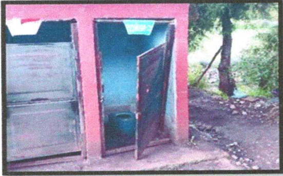
Foto1: SUSTITUCIÓN DE SANITARIOS
