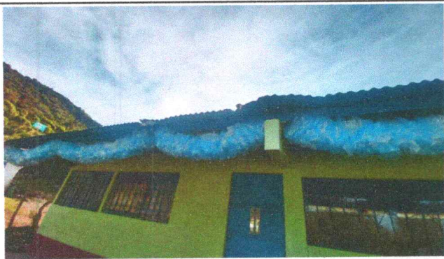
FOTO 3: COLOCACIÓN DE CANAL PVC
