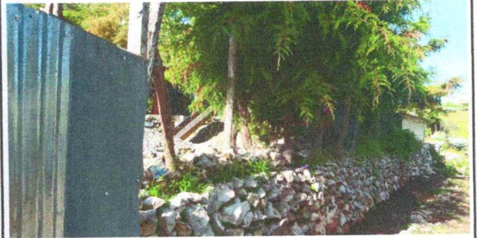
Foto 4: REPARACION DE MURO PERIMETRAL
