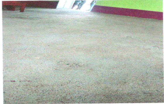
Foto 2: SUSTITUCION DE PISO POR PISO GRANITO EN AULAS
