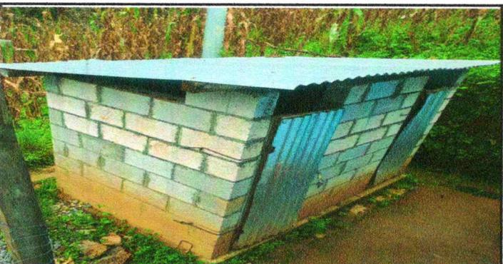
Foto 5: SUSTITUCIÓN LÁMINA EN BAÑOS Y PUERTAS
