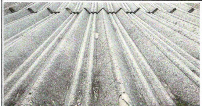
Foto 2: Sustitución de lámina por lámina, por lamina troquelada aluzin calibre 26
