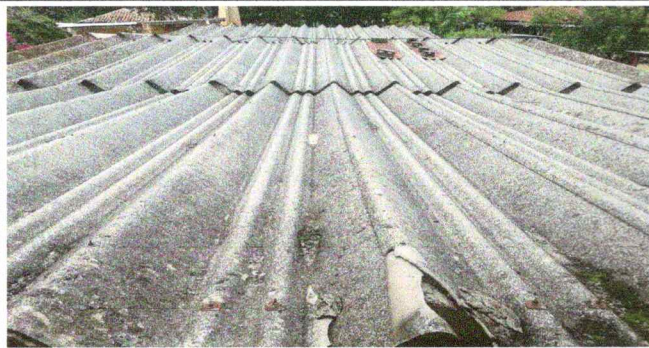
Foto 1: Sustitución de lámina por lámina, por lamina troquelada aluzin calibre 26
