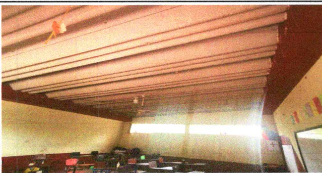
Foto 3: Mejoramiento de estructura de soporte de metal
