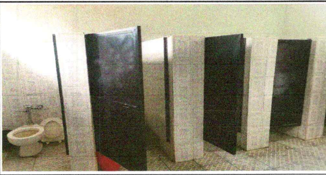
Foto 5: Sustitucion de inodoros y accesorios
