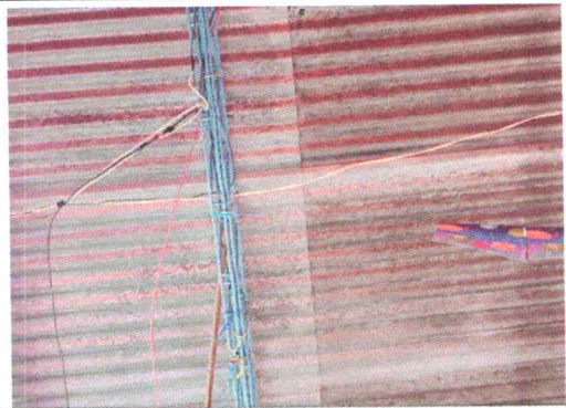
Foto 14: Sustitución de cableado eléctrico
