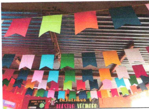
Foto 3: sustitución de estructura de soporte de madera por metal
