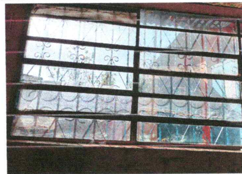
Foto 18: Sustitución de Vidrios
