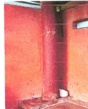
Foto 16 Sustitución de Chimenea
