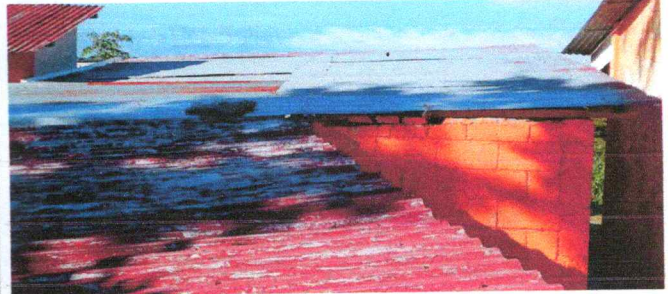
Foto 2: sustitución de lamina, por lamina troquelada aluzinc calibre 26
