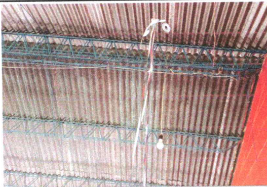
Foto 13: Sustitucion de focos ahorradores por lamparas Led
