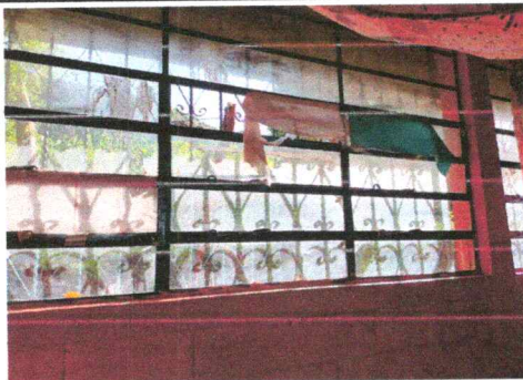
Foto 17: Sustitución de Vidrios
