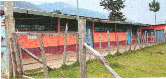
Foto 11: Sustitución de cerco de malla y poste de madera, por tubo hg, malla galvanizada, block, soleras intermedias y columnas
