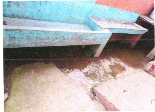
Foto 10: Reparación de piso de torta de cemento
