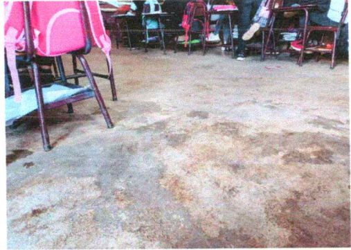
Foto 8: Sustitución de piso de torta de concreto por piso tipo granito de 1"
