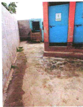
Foto 9: Reparación de piso de torta de cemento
