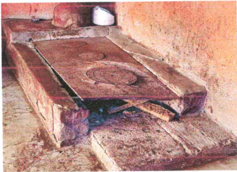
Foto 15: Sustitucion de estufa rural e instalacion de azulejo
