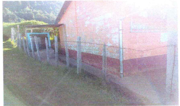
Foto 12: Sustitución de cerco de malla y poste de madera, por tubo hg, malla galvanizada, block, soleras intermedias y columnas
