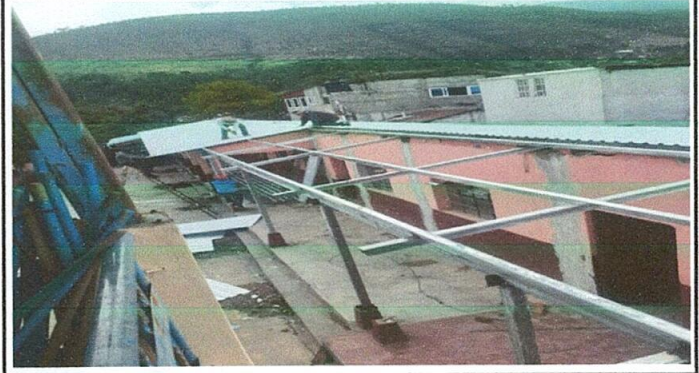
Foto 2: Colocación de estructura
