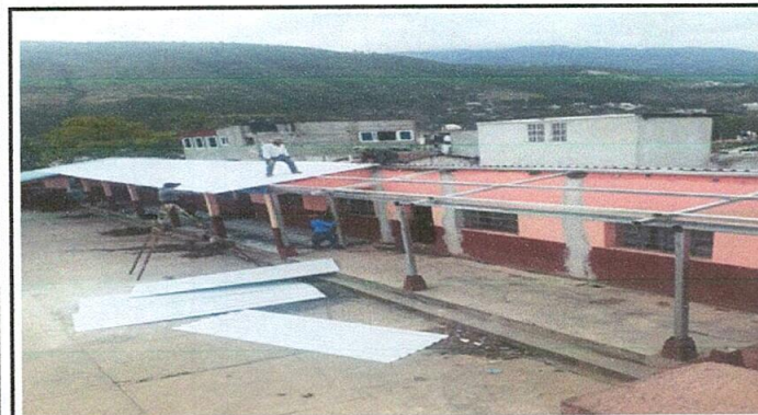
Foto 3: Colocación de techo
