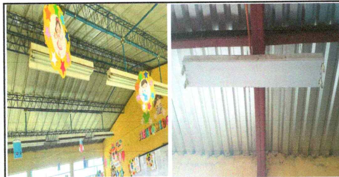
FOTO 11: Sustitución de Plafoneras
