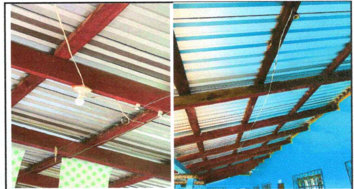
FOTO 16: Sustitución de Cableado eléctrico
