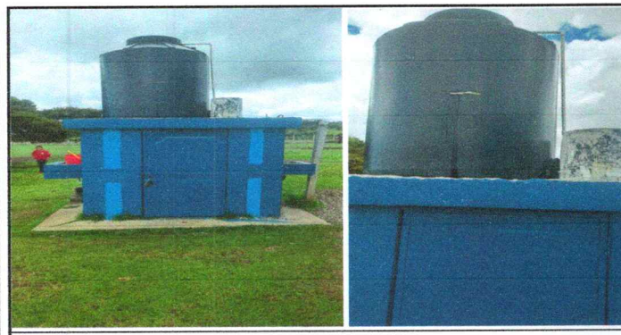
FOTO 17: Sustitución de deposito de agua 1,700 lt
