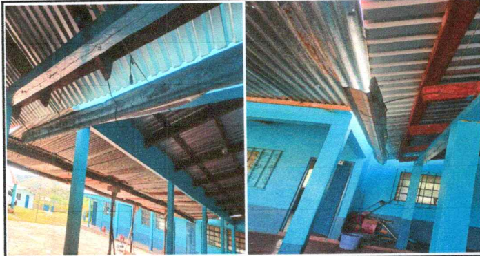
FOTO 7: Sustitución de Canal de Metal
