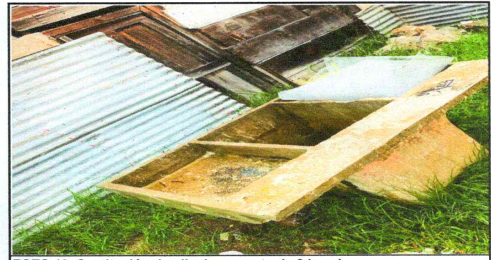
FOTO 18: Sustitución de pila de cemento de 2 lavaderos
