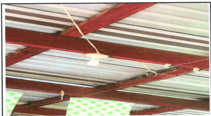
FOTO 10: Sustitución de focos ahorradores
