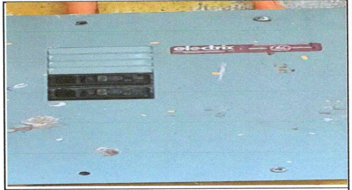
Foto 14: Sustitución de Flipones
