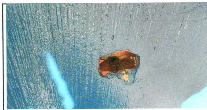
FOTO 12: Sustitución de Interruptores Simples
