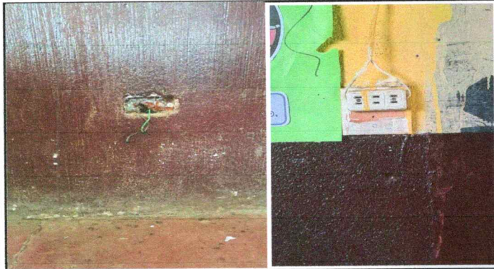
Foto 13: Sustitución de Tomacorrientes Dobles
