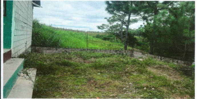
Foto 8: Mejoramiento de pared y soporte de mojinete del techo
