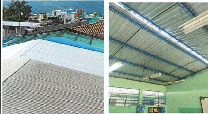
Foto1: Cubierta de lámina por deterioro en cocina y aula de la par de la cocina pues entra demasiada agua.
