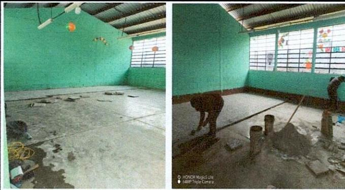
Foto 3: Sustitución de torta de concreto en 3 aulas.
