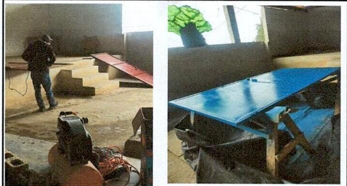
Foto 2: Aplicación de pintura en puertas de metal.
