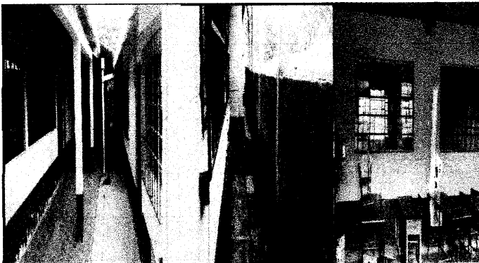
FOTO 9: Pintura de muros exteriores e interiores
