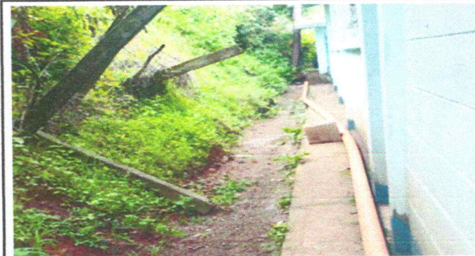
Foto 4: Sustrucción de banqueta de concreto
