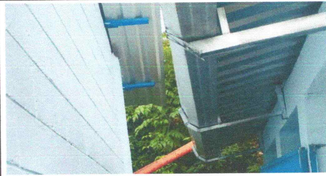
Foto 2: Sustrucción de canal de pvc
