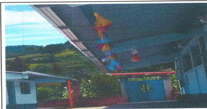
Foto 3: Sustrucción de bajada de agua pluvial, tubo pvc 3"
