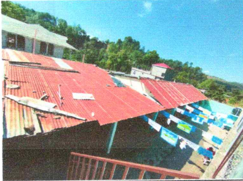
Foto 1: sustitución de lamina, por lamina troquelada
