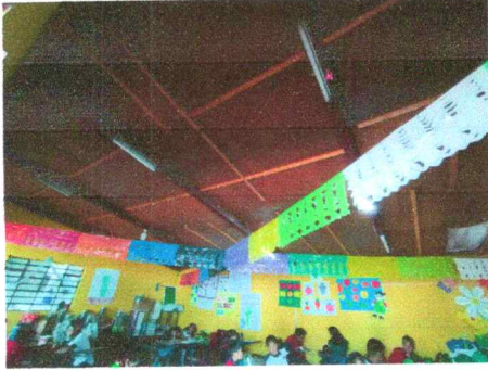
Foto13: sustitución de lámparas tipo led por focos
