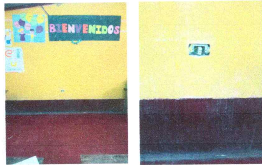
Foto 16: Sustitución tomacorrientes dobles
