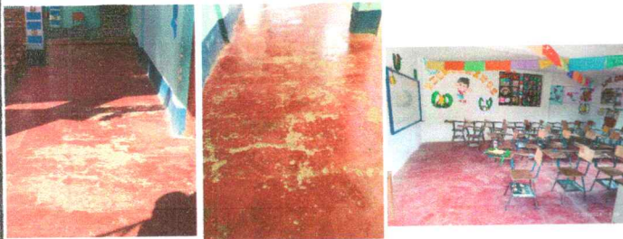
Foto7: Sustrucción de piso de granito
