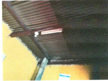
Foto 14: Sustitución de plafoneras
