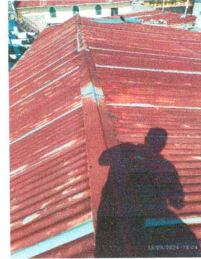
Foto 2: sustitución de capote de lamina, para lamina triquelada.
