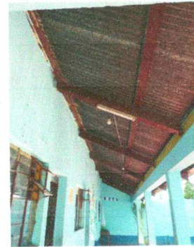
Foto 18: Reparación de cableado eléctrico
