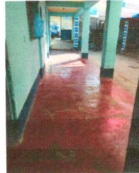
10. Pintura en muros exteriores e interiores
