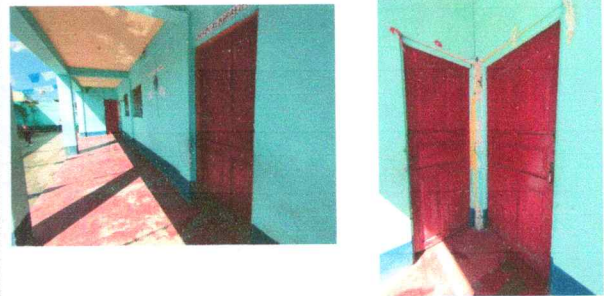
Foto 4: sustitución de puerta
