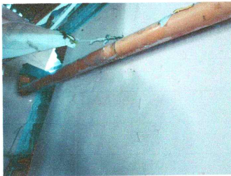
Foto 9: Reparación de bajada de agua pluvial tubo PVC
