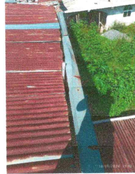
Foto 8: Sustrucción de canal de metal
