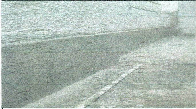
Foto 1: cuneta de concreto
