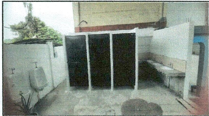
Foto 5: sustitucion de puertas
