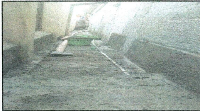
Foto 1: cuneta de concreto
