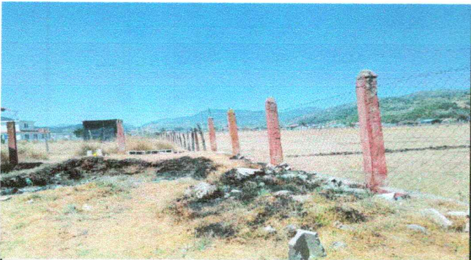
Foto 3: SUSTITUCIÓN DE MALLA POR MALLA EN MURO PERIMETRAL
