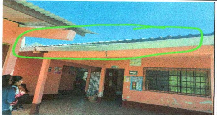
Foto 2: SUSTITUCIÓN DE CANAL DE METAL POR CANAL DE METAL
