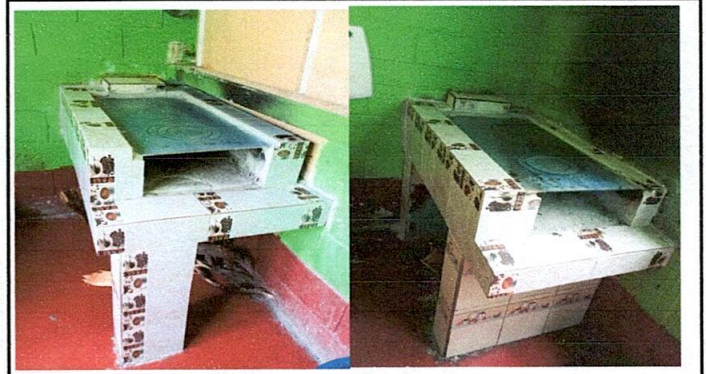
FOTO 10: Sustitución de plancha de metal de 3 hornillas
