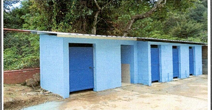
FOTO 4: Sustitución de puertas en servicios sanitarios
