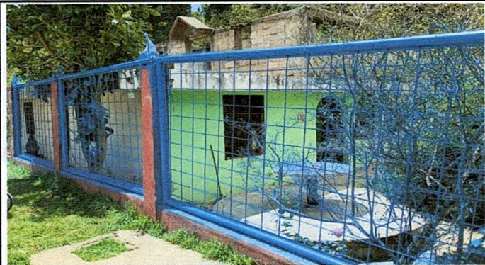
FOTO 9: Sustitución de cuadros de malla por cuadros de electromalla
