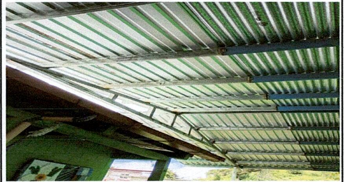
FOTO 2: Ampliación de soporte de metal en área de aula (incluye costaneras, postes de hierro hg) y sustitución de lamina troquelada calibre 26
