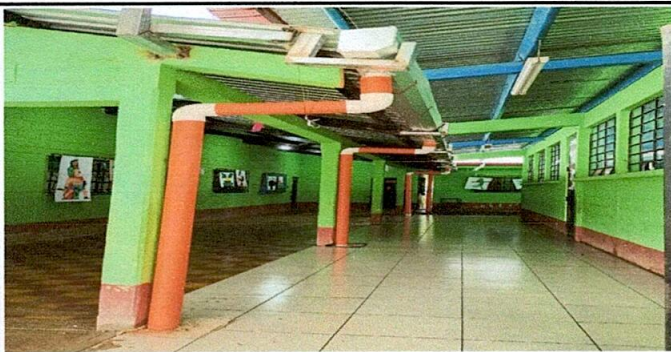
FOTO 5: Sustitución de canal de metal (incluye soporte)
