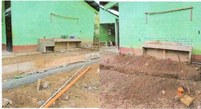
FOTO 1: Sustitución de soporte de madera por metal (incluye costaneras, tubos de metal hg) de área de lavamanos y sustitución de lamina troquelada calibre 26
