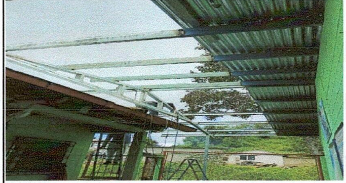
FOTO 2: Ampliación de soporte de metal en área de aula (incluye costaneras, postes de hierro hg) y sustitución de lamina troquelada calibre 26
