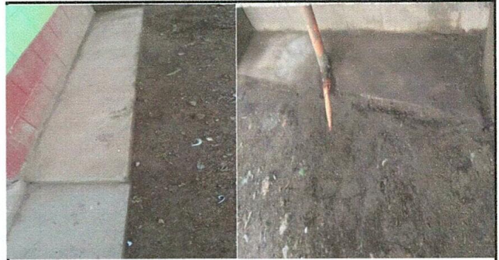
FOTO 12: Ampliación torta de cemento en área de lavamanos
