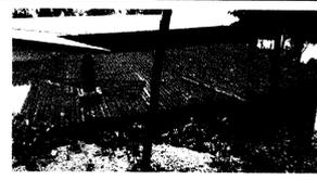
Foto 4: Sustitución de lámina, por lámina troquelada. La cocina de la EORM Aldea Buena Vista San Isidro necesita un cambio de lámina pues las existentes se ven muy maltratadas por las inclemencias del tiempo.
