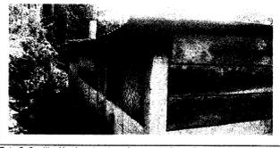
Foto 5: Sustitución de estructura de soporte de madera, por metal. La cocina del centro educativo se encuentra con una estructura de madera en malas condiciones y es necesario sustituirla por seguridad.
