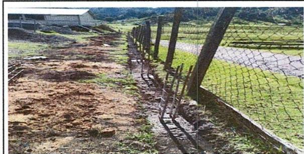
FOTO 5: FUNDICION DE HIERRO PARA MURO PERIMETRAL.
