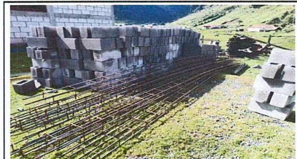
FOTO 4: ELABORACION DE ESTRUCTURA DE HIERRO PARA MURO PERIMETRAL.
