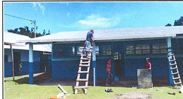
FOTO 12: SUSTITUCION DE CANALES PVC, PESCANTES Y TUBOS PVC DE BAJADAS DE AGUA DE LLUVIA.
