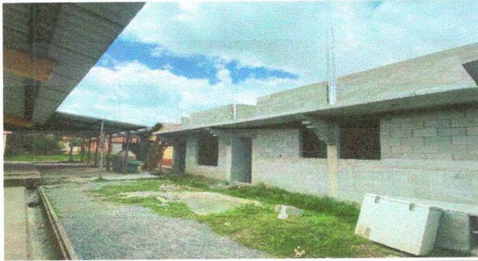
Foto1: Mejoramiento de lámina, por lámina troquelada Aluzinc calibre 26
