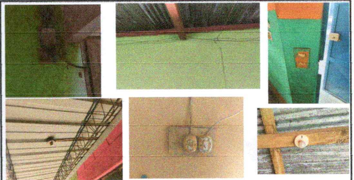
Foto 6: Reparación de sistema eléctrico.
