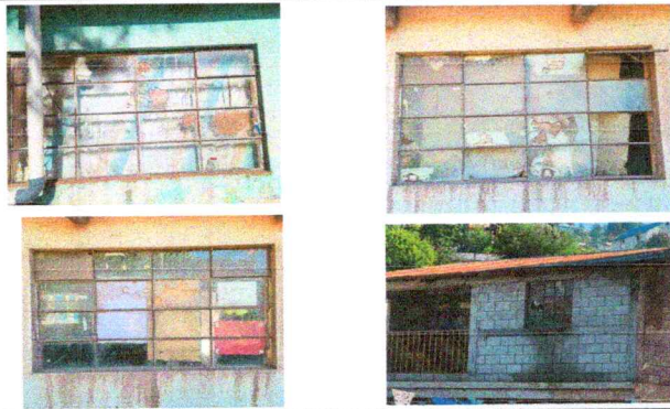
Foto 3: Ventanas: Sustitución de vidrios y balcones.
