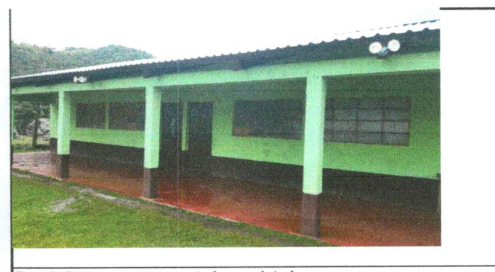
Foto 6: Pintura en muros exteriores e interiores
