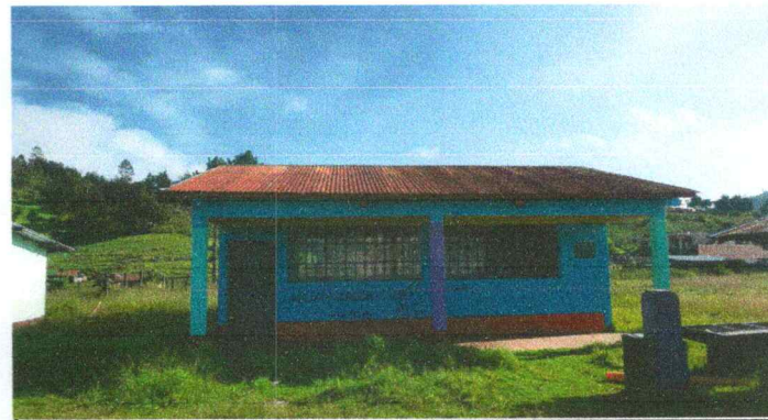
Foto 4: Sustitución de lamina por lamina troquelada calibre 26
