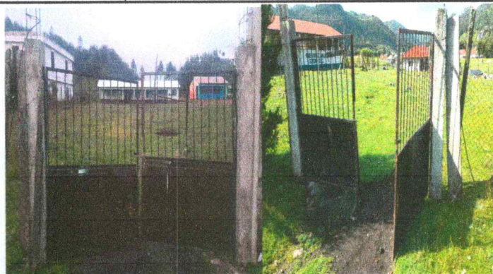
Foto 2: Sustitución de portón de acceso principal
