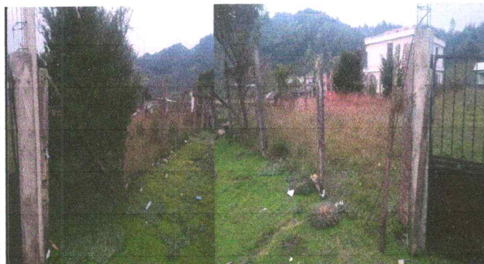
Foto 3: Reparación de muro perimetral
