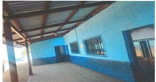
foto 4: Pintado de Aulas
