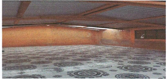
Foto2: instalacion de piso
