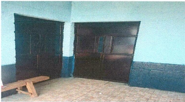
foto 3: Reparación de puertas
