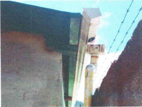
Foto 7: Sustitución de canal de pvc y reparación de bajada de agua pluvial
