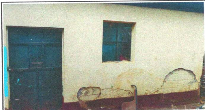
Foto 22: Reparación de repello y cernido de paredes
