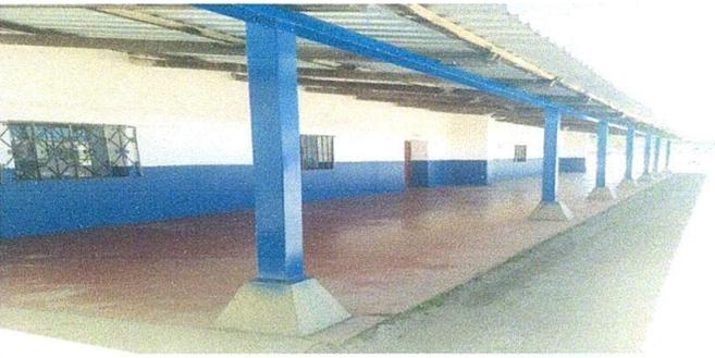
Foto 5: Sustitución de postes de soporte de madera por metal
