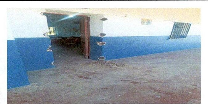
Foto 6: sustitución de puertas de madera por metal y pintura de puertas de metal
