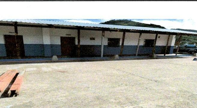
Foto 5: Sustitución de postes de soporte de madera por metal
