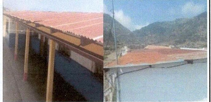
Foto 2: láminas en malas condiciones
