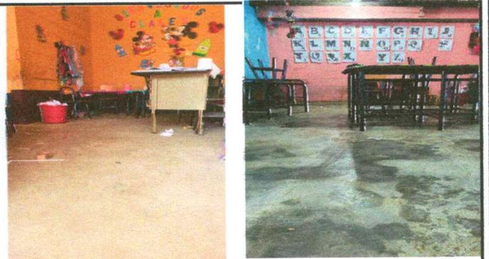
Foto 6: Sustitución de piso de cemento (concreto, líquido) por piso granito
