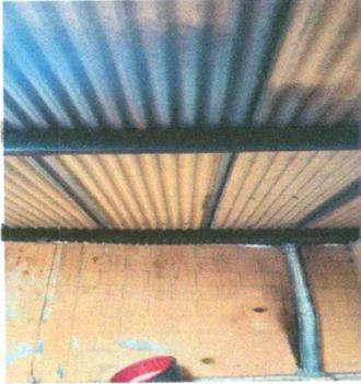
Foto1: Sustitución de lámima, por lámina troquelada aluzinc calibre 26
