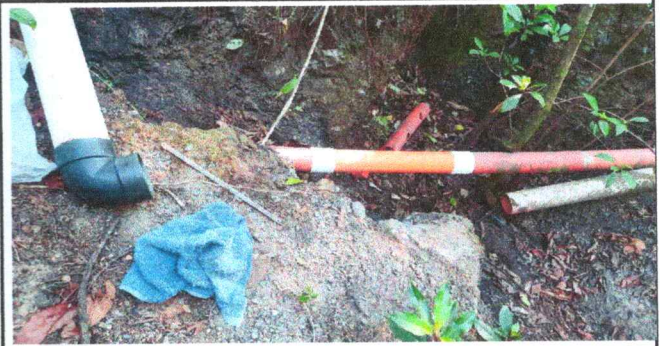
Foto 8: Sustitución de tubería PVC línea principal aguas negras
