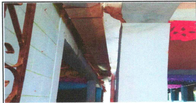
Foto 4: Sustitución de canal de metal
