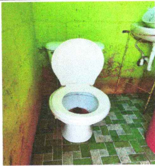
Foto 7: Sustitución de inodoros
