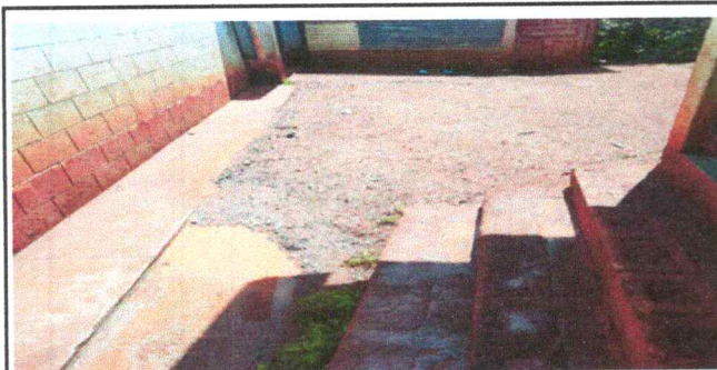
Foto 5: Reparación de cuneta de concreto
