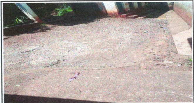
Foto 2: Reparación de piso de concreto
