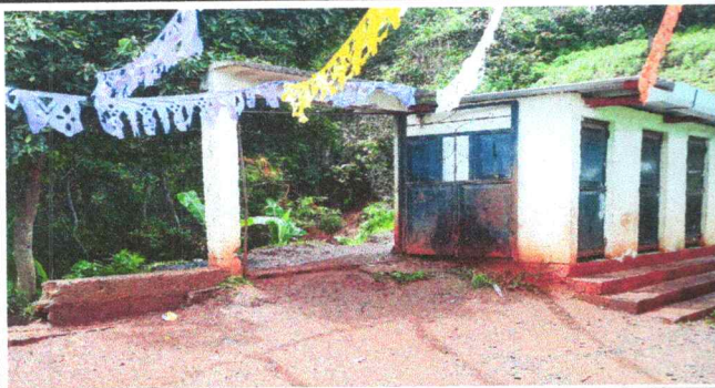
Foto1: Sustitución de portón de metal por porton de metal
