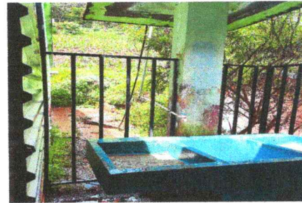
Foto 10: Sustitución de llave de chorro
