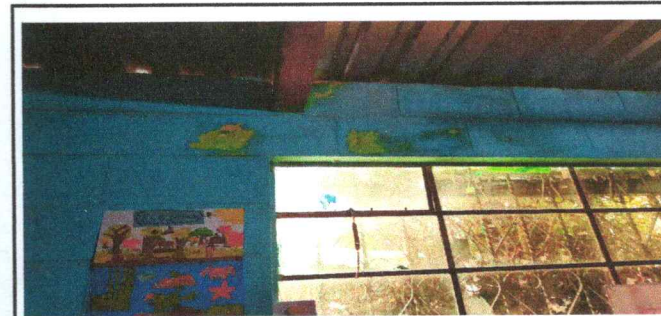
Foto 6: Pintura en muros exteriores e interiores
