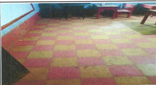
Foto 3: Sustitución de piso de granito por piso de granito
