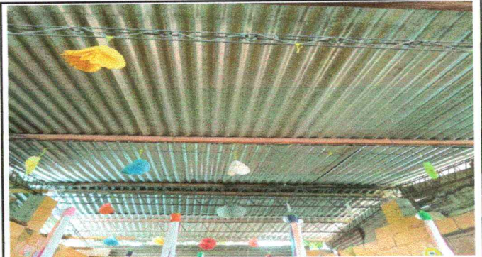
Foto 2: Sustitución de soporte de metal por metal
