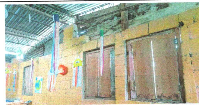
Foto 5: Sustitución de estructura de metal de ventana
