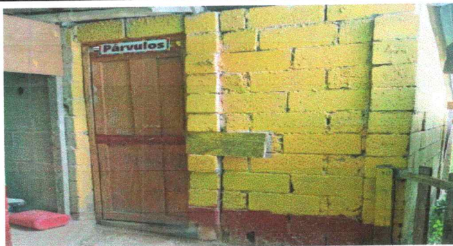
Foto 3: Sustitución de puerta de metal de aula
