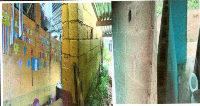
Foto 13: Repello y cernido de paredes de aula y baño
