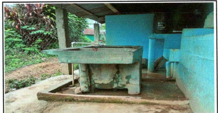
Foto 10: Sustitución de pila de cemento de dos lavaderos
