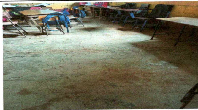
Foto 7: Sustitución de piso de torta de cemento por piso granito
