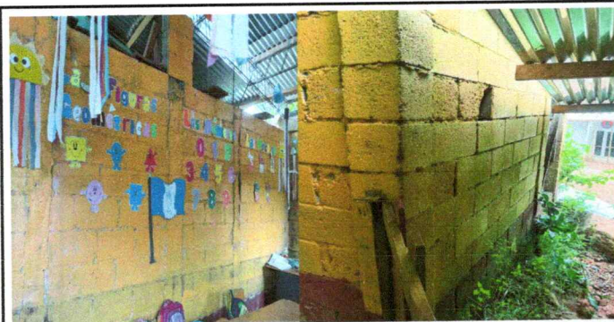
Foto 11: Mejoramiento de paredes de aula
