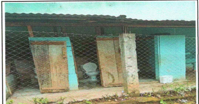
Foto 4: Sustitución de puerta de metal de baños
