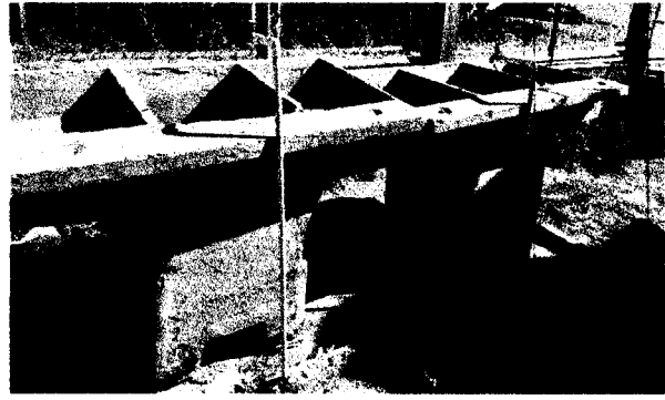
Foto 8: Sustitución de pilas y planchas de cemento
