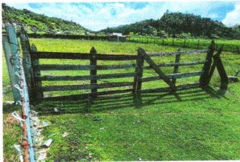
Foto 5: PORTÓN DE INGRESO
