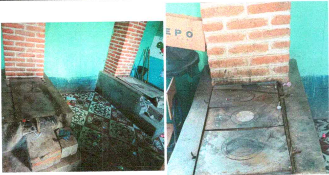
Foto 3: Sustitución de planchas de metal de 3 hornillas por planchas de metal de 3 hornillas
