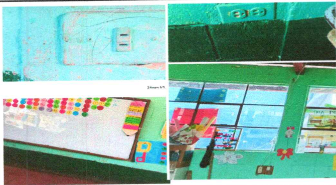
Foto 3: Sustitución de interruptores simples y dobles
