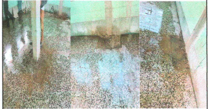
Foto 4: Reparación de piso granito
