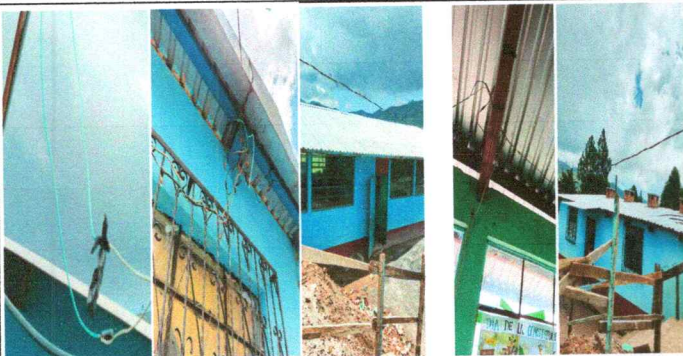
Foto 5: Sustitución de cableado electrico/Sustitución de ducto electrico mas accesorios
