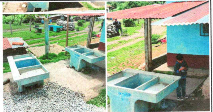
Foto 4: Sustitución de pilas de cemento de 2 lavaderos por pilas de plastico de 2 lavaderos
