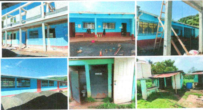
Foto1: Pintura de muros exteriores e interiores
