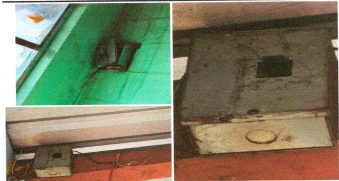
Foto 4: Sustitución de flipones de 1x20/ Sustitución de flipon de 1x40/ Sustitución cajas de flipon tipo BH
