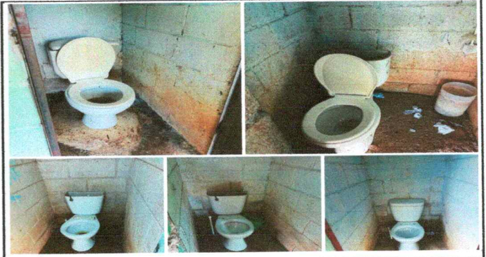
Foto 2: Sustitución de inodoros
