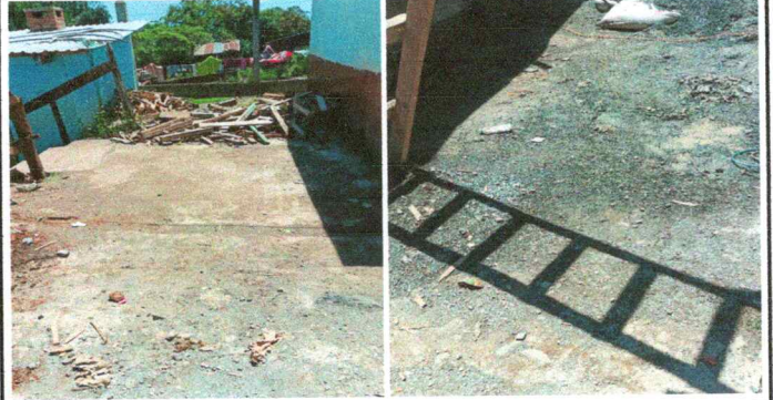
Foto 2: Reparacion de planchas de concreto de patio
