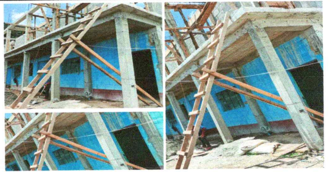
Foto1: Aplicación de repello de muros internos, externos y cielo
