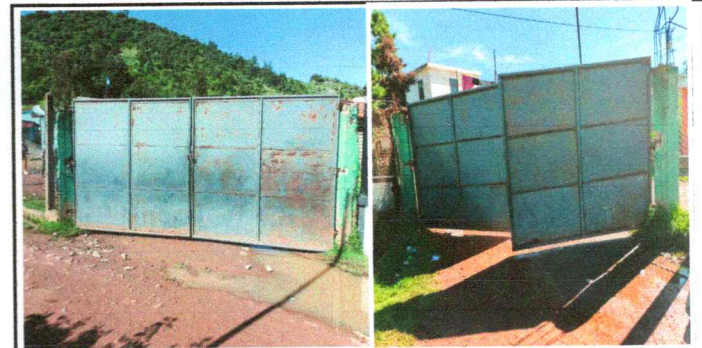
Foto 6: Mantenimiento de porton de metal
