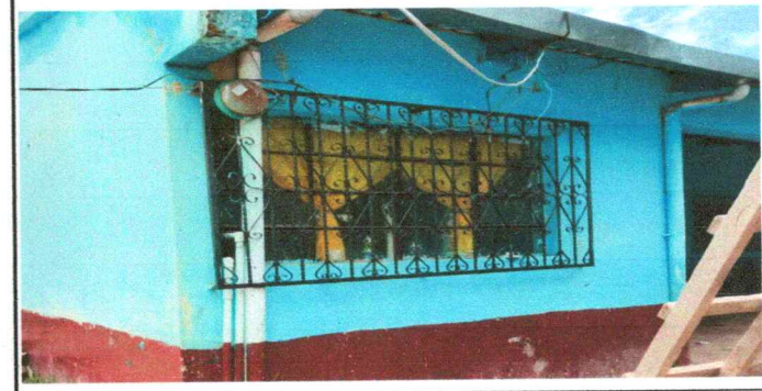
Foto 6: Sustitución de timbre de campana
