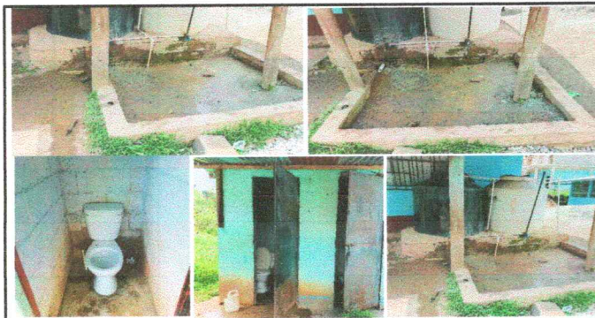
Foto 5: Reparación de piso de torta de concreto
