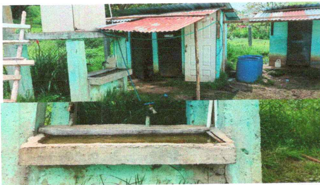
Foto 3: Sustitución de lavamanos de concreto por lavamanos de porcelana
