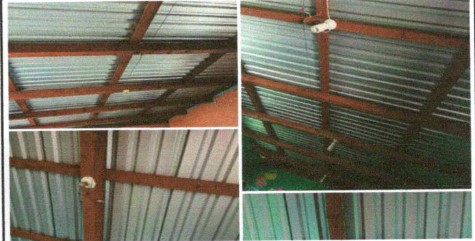
Foto 2: Sustitución de plafoneras
