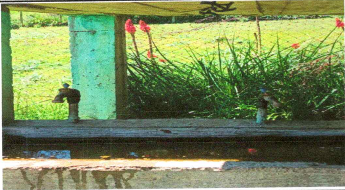
Foto1: Sustitución de llaves de chorro
