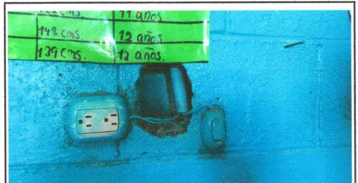
Foto 4: Sustitución de tomacorriente y apagador
