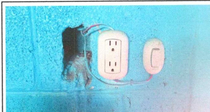
Foto 5: Sustitución de tomacorriente y apagador
