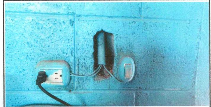
Foto 6: Sustitución de tomacorrientes y apagador
