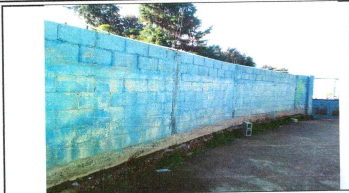
Foto19: renglon No. 14 repello de muros perimetrales,
