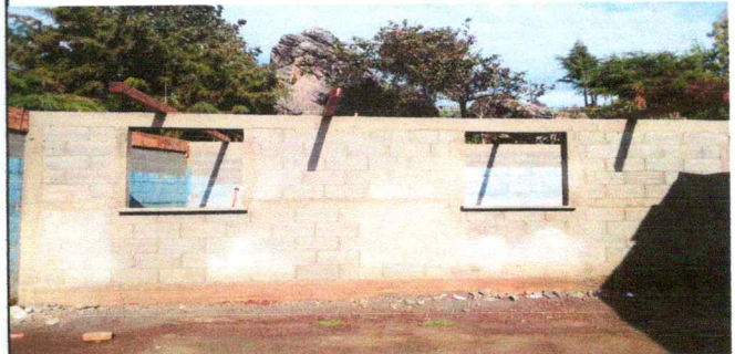
Foto 6: renglon 5 sustitucion a estructura de metal de ventanas
