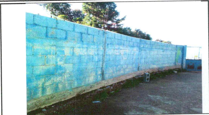
Foto13: renglon No. 10 muros perimetrales, reparacion de muros perimetrales
