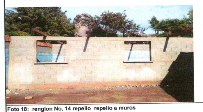
Foto 18: renglon No, 14 repello repello a muros
