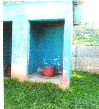
Foto 10: renglon No. 7 servicios sanitarios, reparacion cepillado, sujecion, y pintado de puertas de sanitarios
