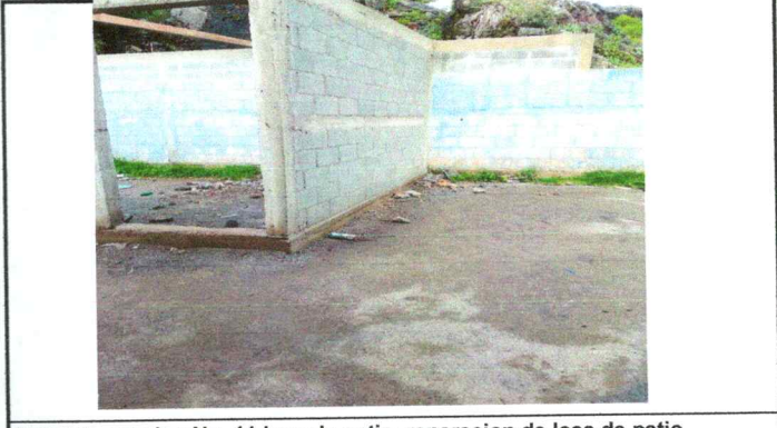
Foto 14: renglon No. 11 losa de patio, reparacion de losa de patio
