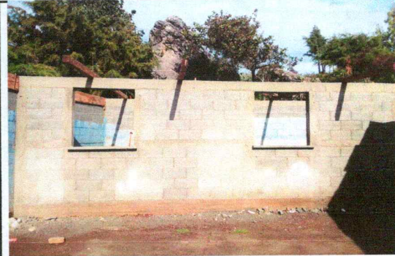
Foto 2. renglón No. 1 cubierta de lamina
