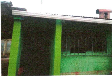
Foto 9: renglon No. 6 canales y bajadas de agua
