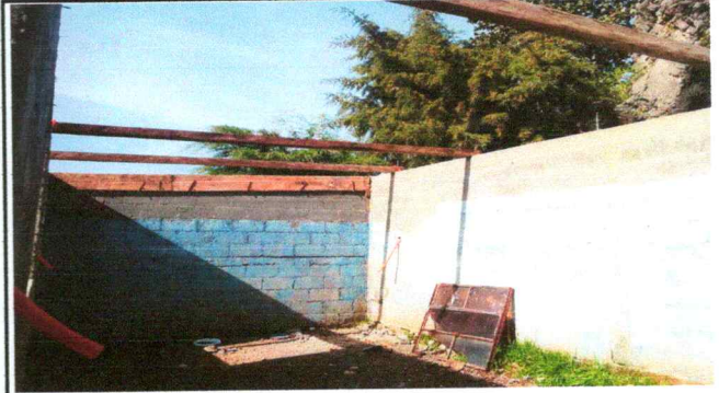
Foto 8: renglon No. 5 piso
