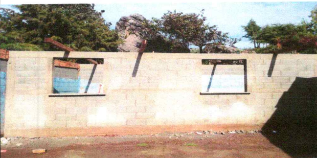
Foto 3. renglón No. 2 estructura de techo
