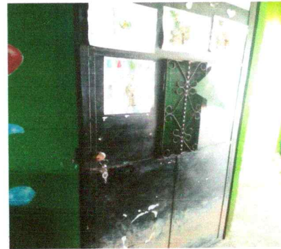
Foto 4: renglón No. 3 reparacion de puertas de metal
