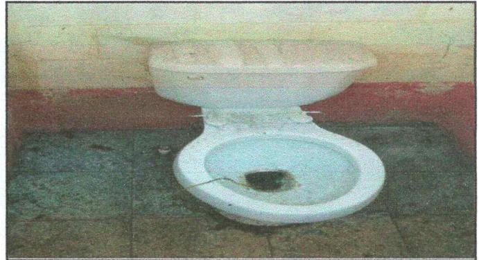
SUSTITUCION DE INODOROS
