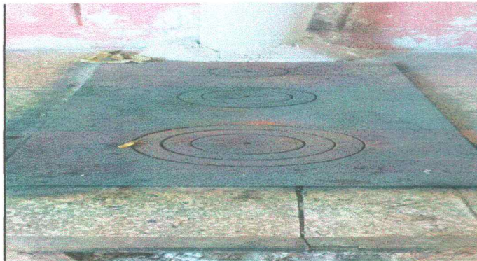
SUSTITUCION DE PLANCHA
