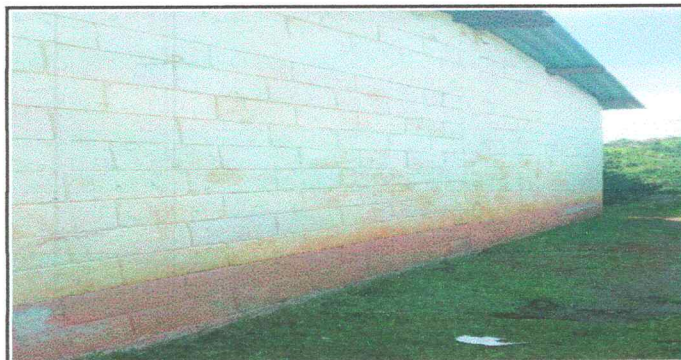
PINTURA DE MUROS DE EXTERIORES E INTERIORES
