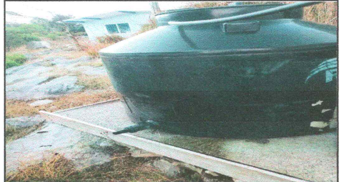
SUSTITUCIÓN DE DEPOSITO DE AGUA
