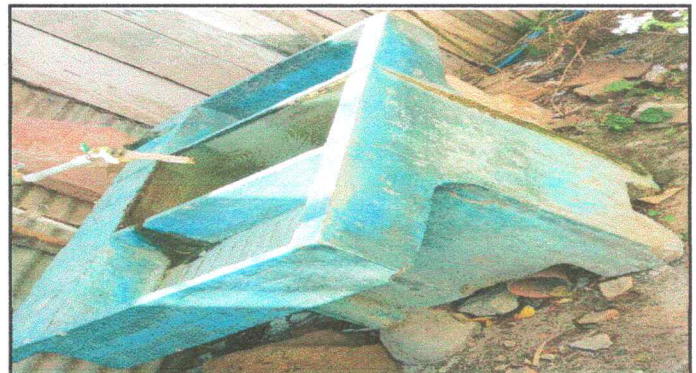
SUSTITUCION DE PILA DE CEMENTO
