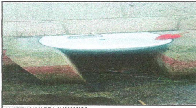
SUSTITUCION DE LAVAMANOS
