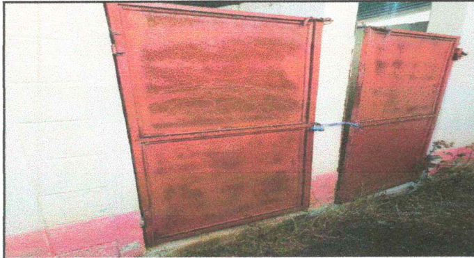
SUSTITUCIÓN DE PUERTA EN SERVICIO SANITARIO
