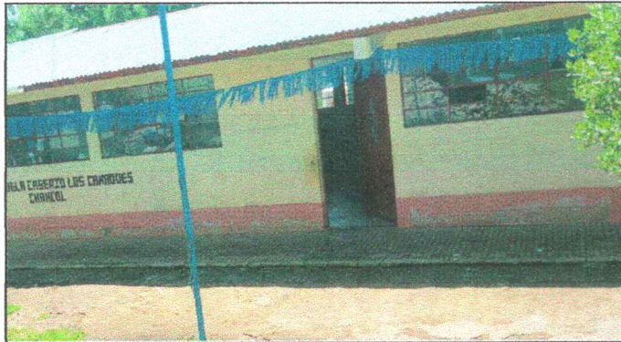
REPARACION DE PLANCHAS DE CONCRETO DE PATIO
