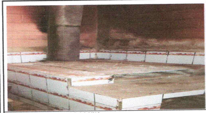
FOTO 3: REPARACION DE COCINA
