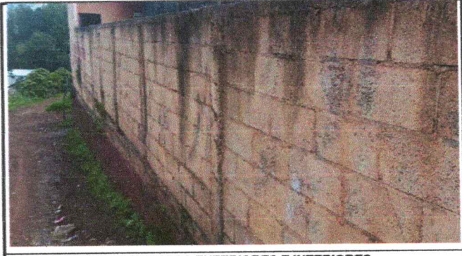
FOTO 2: PINTURA EN MUROS EXTERIORES E INTERIORES
