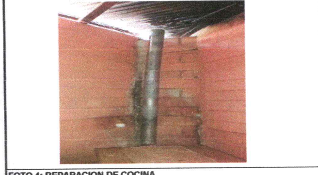
FOTO 4: REPARACION DE COCINA
