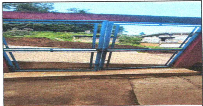
FOTO 6: SUSTITUCIÓN DE PORTON POR PORTON CORREDIZO
