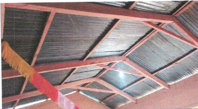
FOTO 3: SUSTITUCIÓN DE ESTRUCTURA DE MADERA POR METAL
