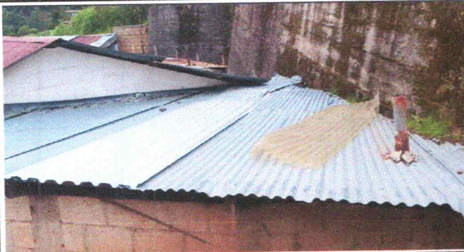
FOTO 1: SUSTITUCIÓN DE LAMINA A LAMINA TROQUELADA
