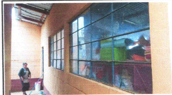
FOTO 4: MEJORAMIENTO DE BALCONES
