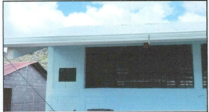
Foto 4: Sustitución de canal de metal por canal de pvc
