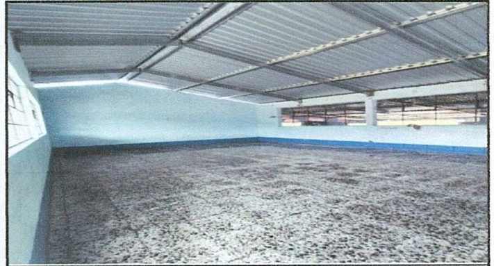
Foto 2: Sustitución de soporte de madera por metal
