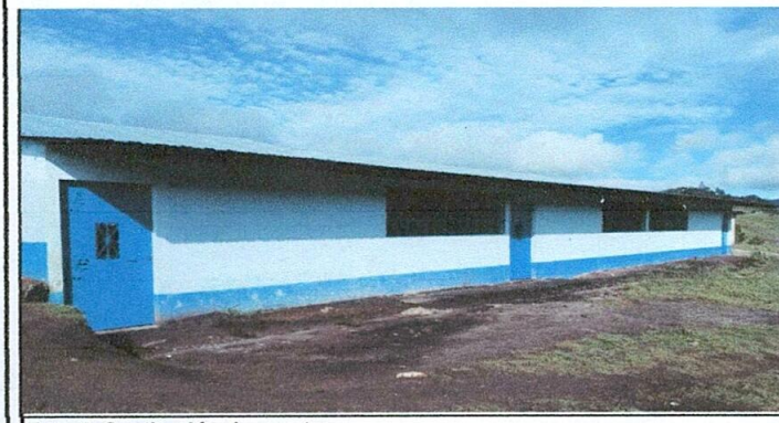
Foto 5: Sustitución de puertas
