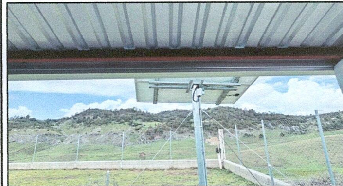
Foto 3: Sustitución de canal de metal por canal de pvc
