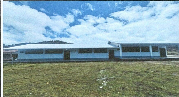
Foto 1: Sustitución de lámina por lámina troquelada calibre 26
