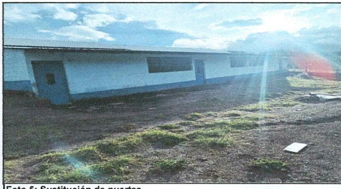
Foto 5: Sustitución de puertas
