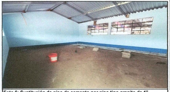
Foto 6: Sustitución de piso de cemento por piso tipo granito de 1"
