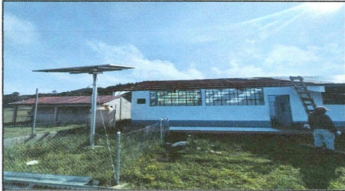
Foto 1: Sustitución de lámina por lámina troquelada calibre 26
