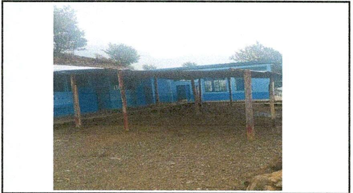
FOTO 2: SUSTITUCIÓN DE ESTRUCTURA DE MADERA, POR METAL
